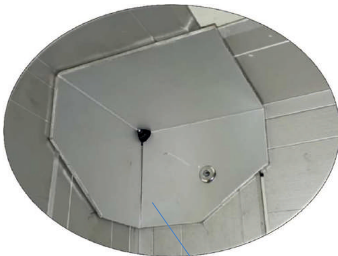
5 000 231 - Pokrycie zabezpieczające przykleić lub przynitować zarówno z przodu jak i z tyłu
